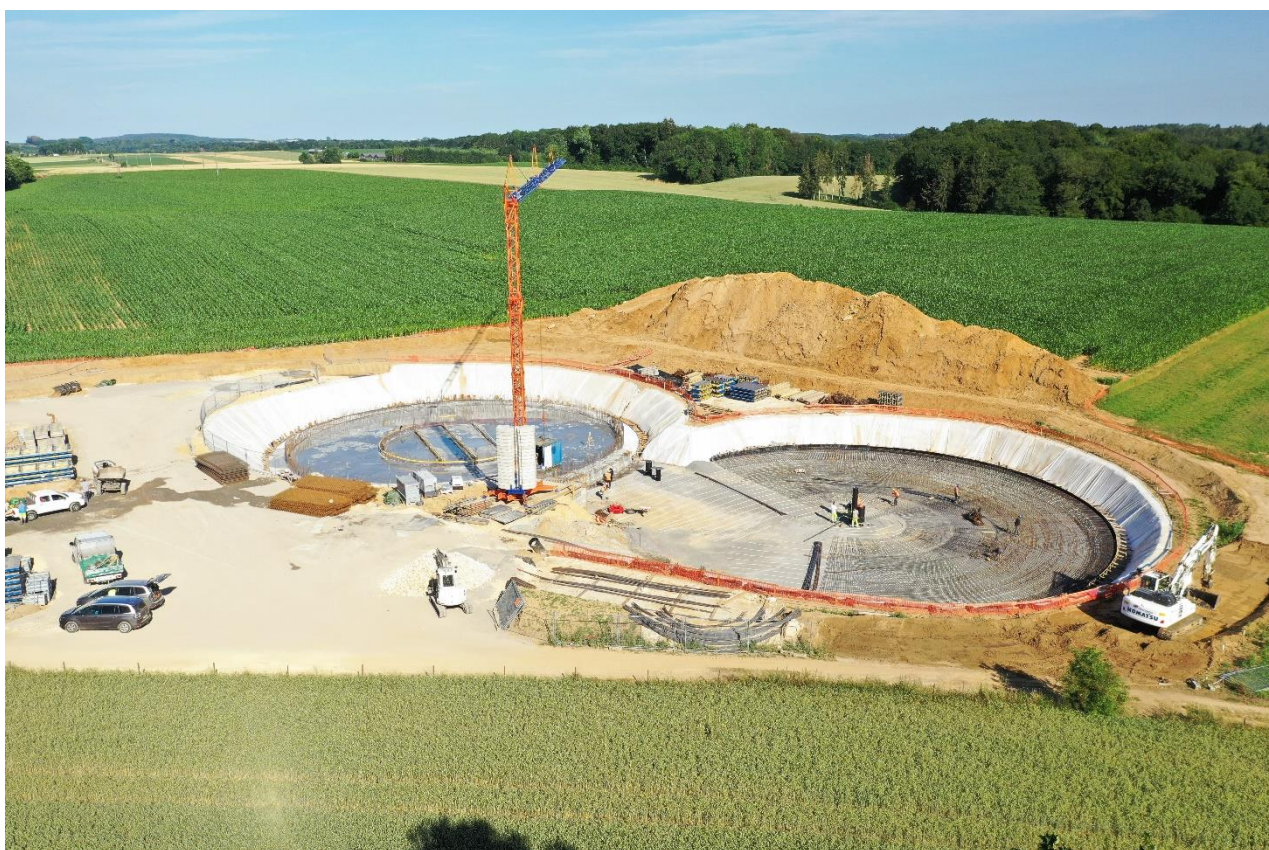
Chantier de la nouvelle station d'épuration transfrontalière à Steinfort en 2019
