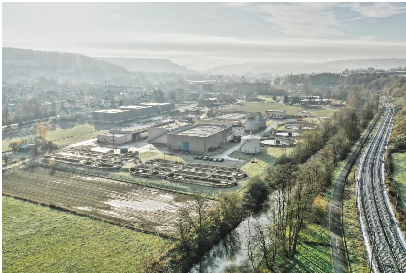
Station d'épuration à Beringen en 2019
