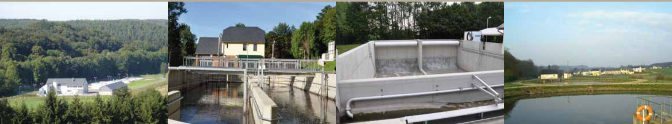
Station d'épuration biologique de Boevange/Attert
