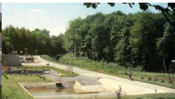
Station d'épuration de Steinfort
