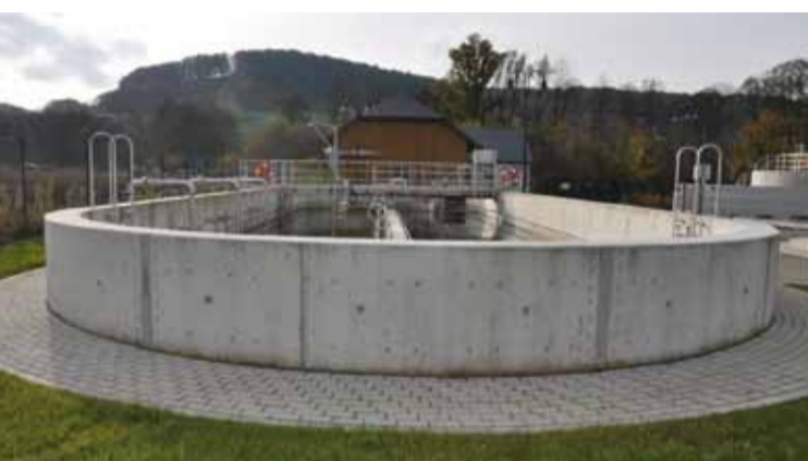
Station d'épuration de Dondelange
