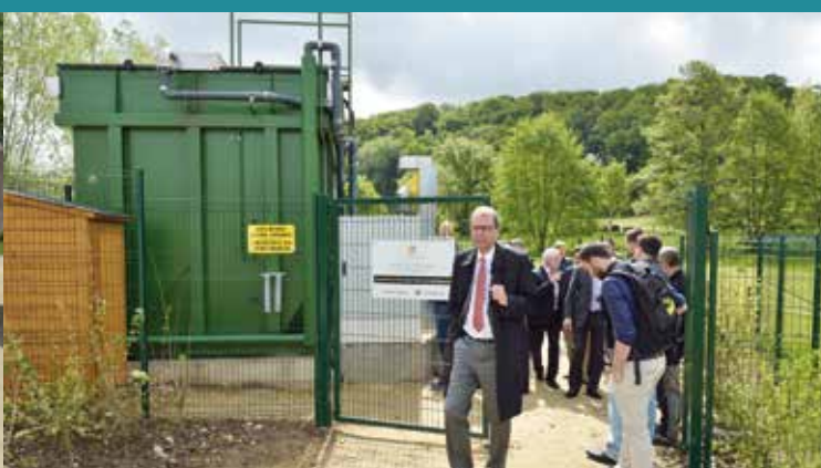
Schwebach - Inauguration station d'épuration provisoire / Einweihung provisorische Kläranlage - 01.06.2015
