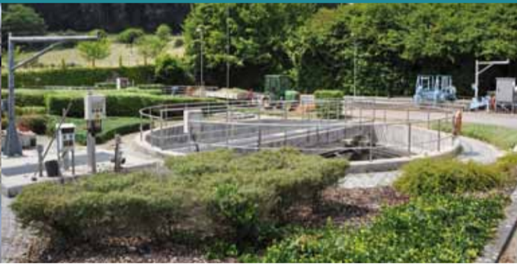
Hobscheid, station d'épuration / Kläranlage
