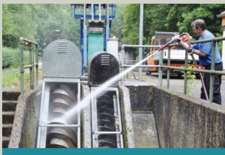
Rinçage de la station de pompage Steinfort Spülen des Pumpwerks Steinfort
