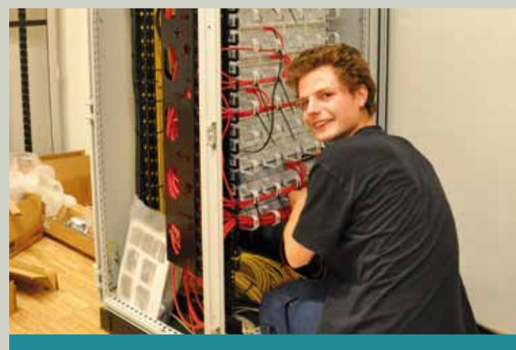
Travaux de réseau informatique Netzwerkarbeiten
