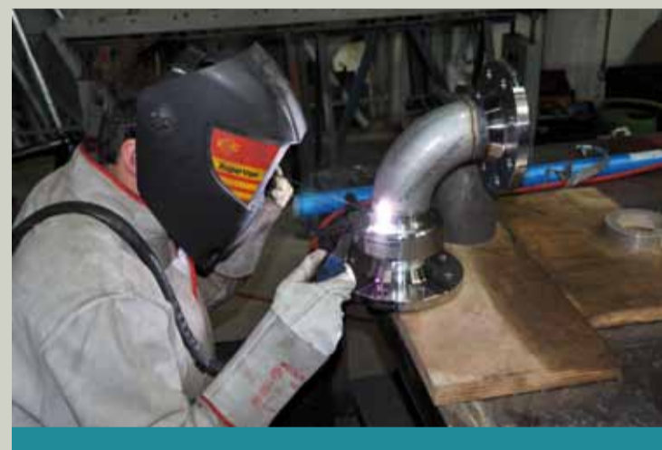
Travaux de soudage Schweißarbeiten
