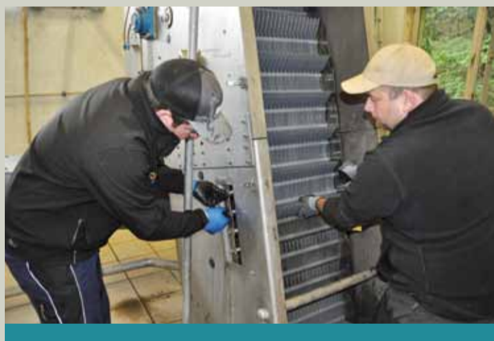
Réparation du dégrilleur STEP Mamer Reparatur des Feinrechen STEP Mamer
