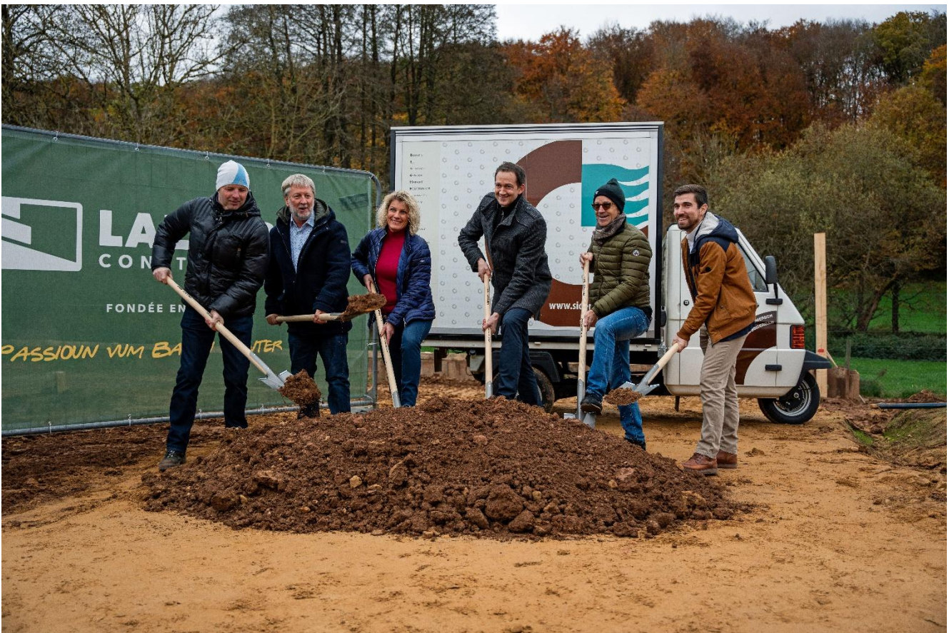
Coup de bêche de la station d'épuration de Nagem, le 12 novembre 2024
