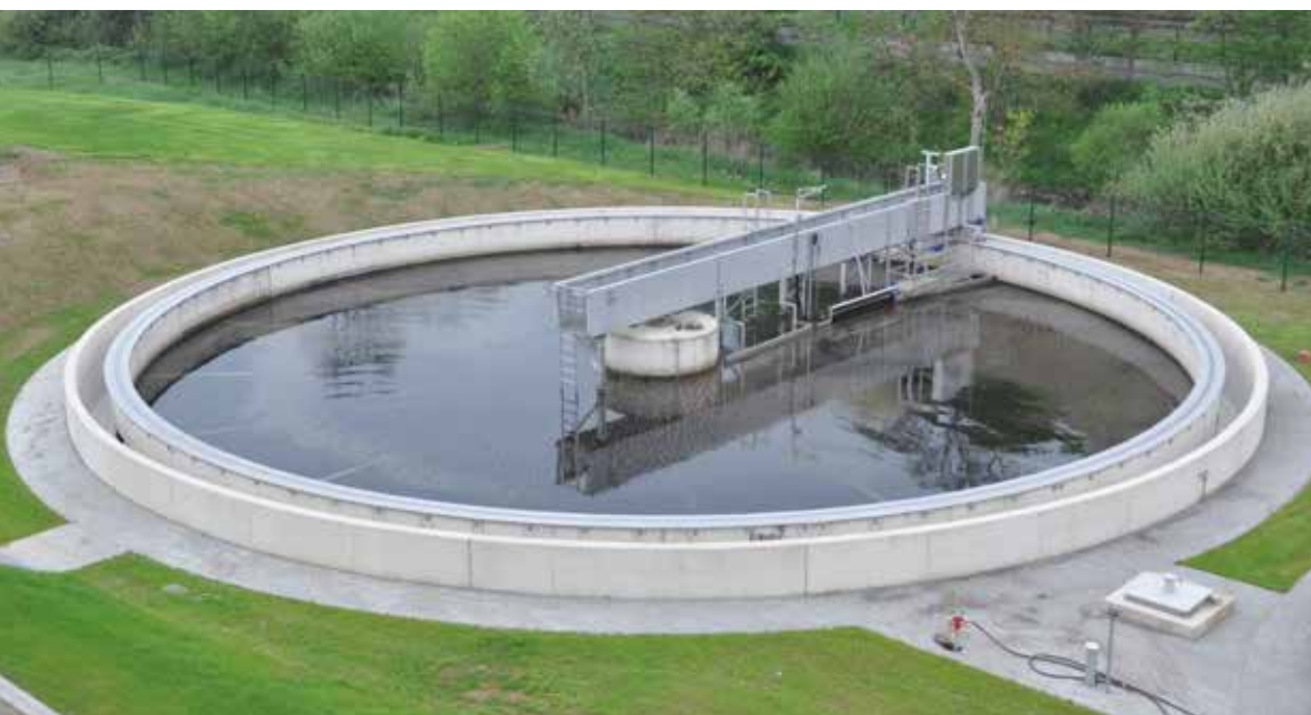
Station d'épuration à Beringen/Mersch.
