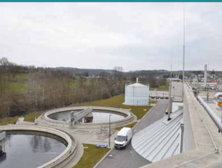
Mersch - Kläranlage / Station d'épuration.
