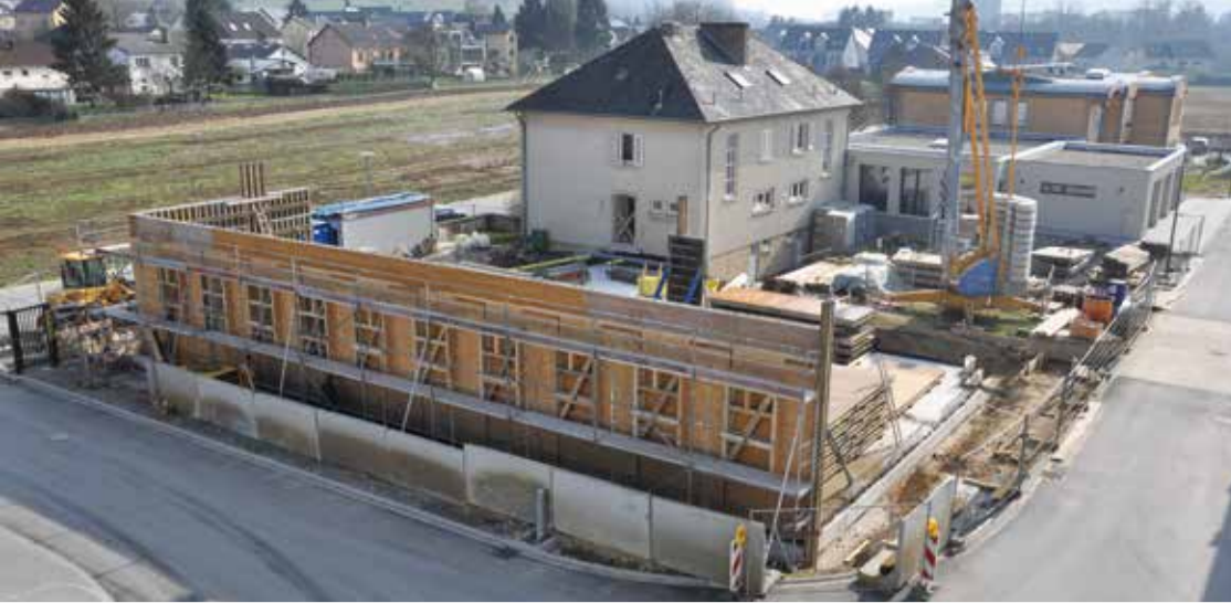
Baustelle Zentrales Labor / Chantier laboratoire central.
