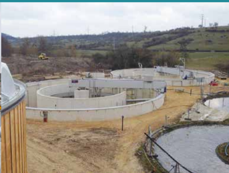
Kläranlage Junglinster, links die neuen Becken, rechts die alte Anlage / Station d'épuration de Junglinster, à gauche les nouveaux bassins biologiques, à droite l'ancienne station.
