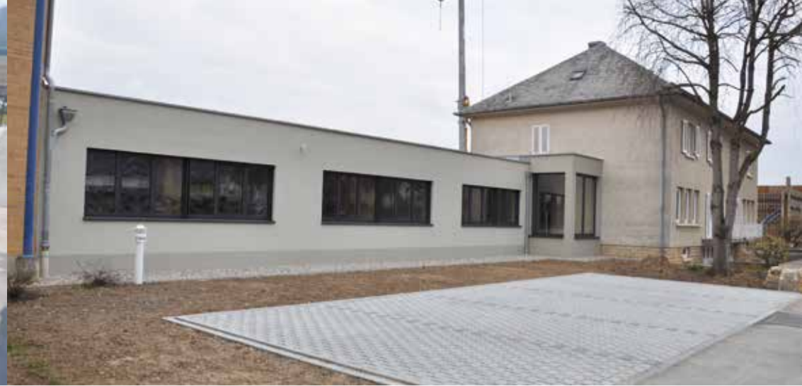
Erweiterung der Verwaltungsgebäudes / Extension du bâtiment administratif.
