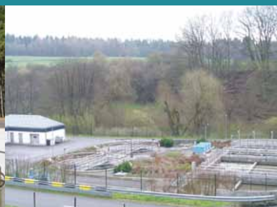
Hobscheid, station d'épuration / Kläranlage
