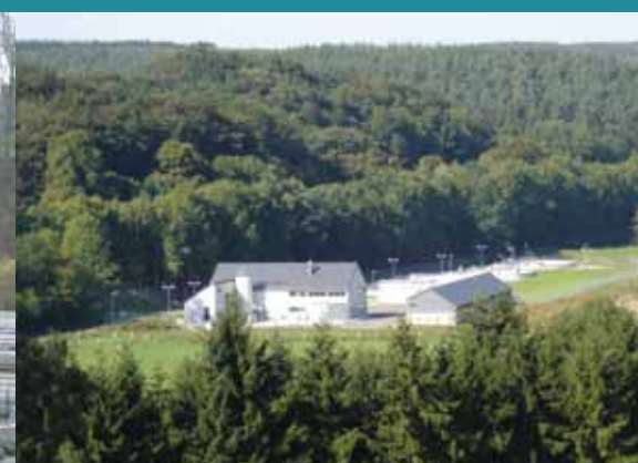
Boevange/Attert, station d'épuration / Kläranlage
